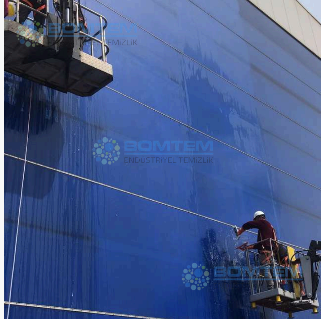
KAPI BRANDA FABRİKA TEMİZLİĞİ (SONRASI)
