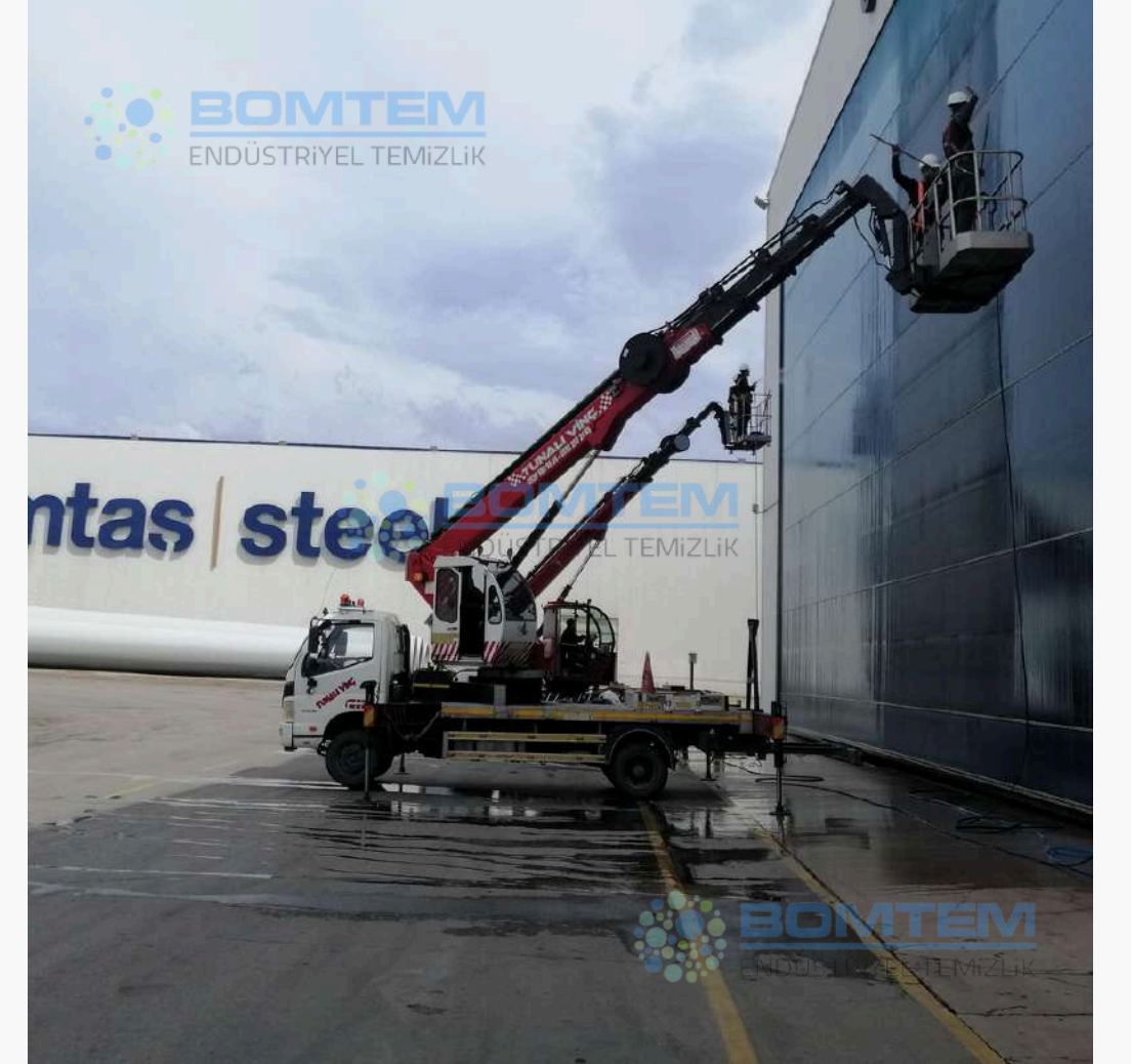
KAPI BRANDA FABRİKA TEMİZLİĞİ (GENEL GÖRÜNÜM)
