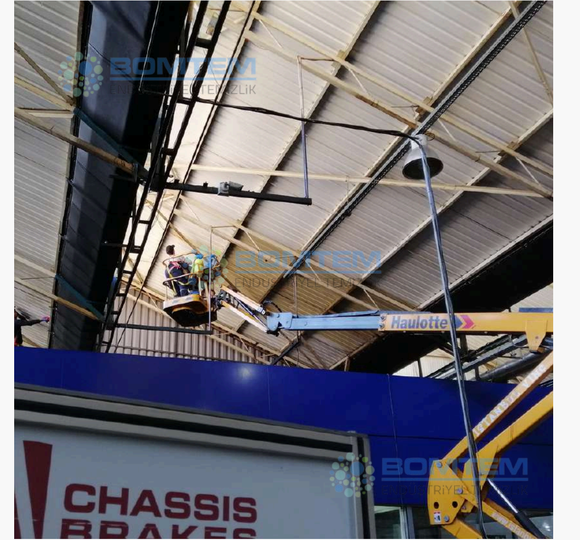
TAVAN PANEL FABRİKA TEMİZLİĞİ (GENEL GÖRÜNÜM)
