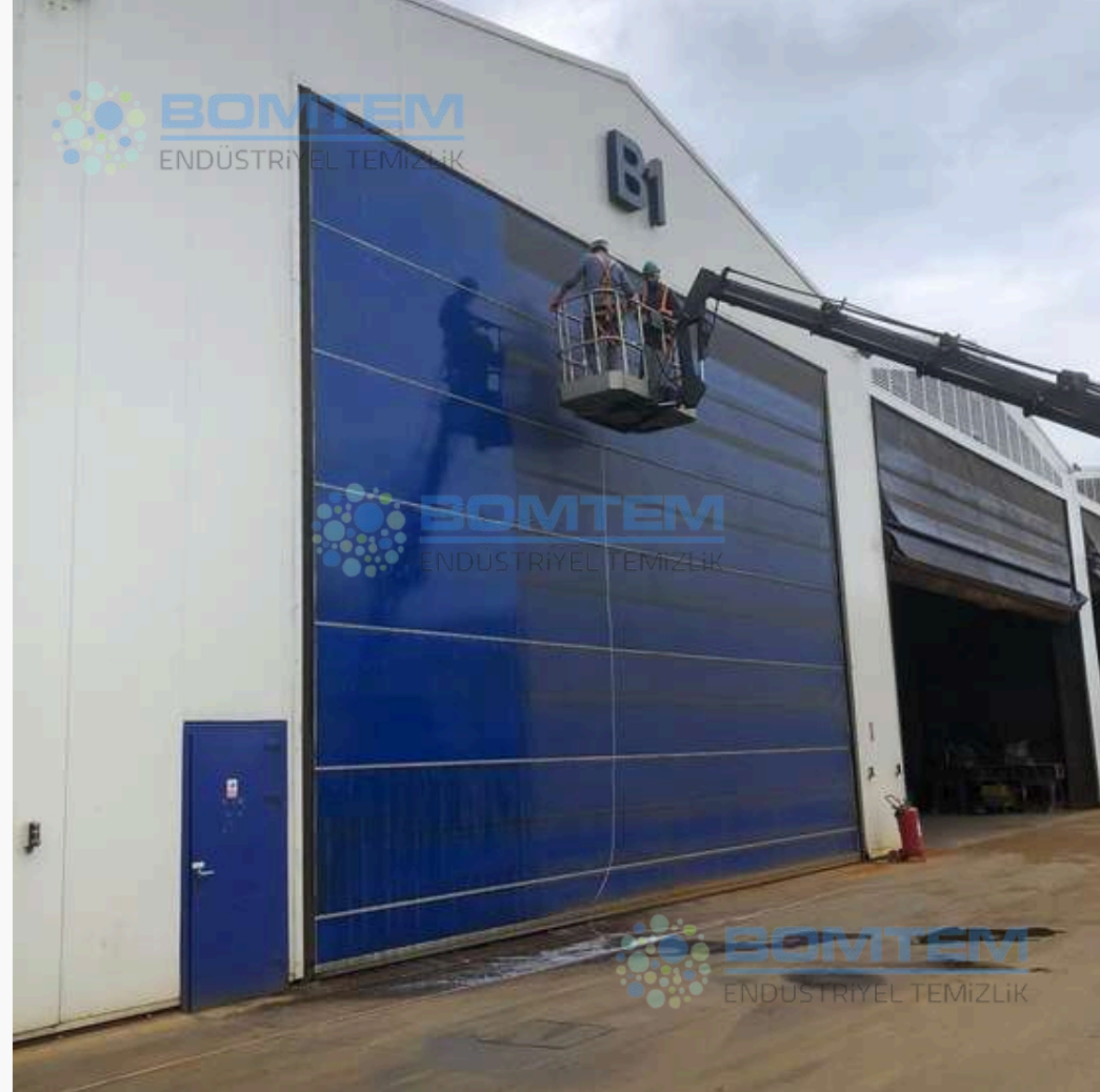
KAPI BRANDA FABRİKA TEMİZLİĞİ (ÖNCESİ)
